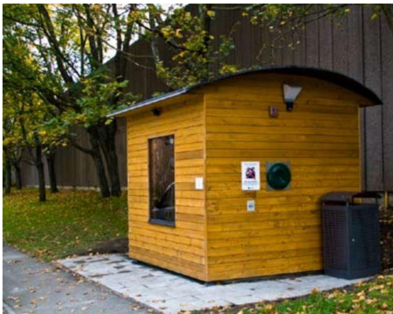
Figur 16. Miljöhus byggt som referensanläggning för konceptet Somnus utvecklat av Smedlund Miljösystem AB. Papperspåse med matavfall lämnas i inkastet på kortsidan. Luckan till inkastet är låst och öppnas med elektronisk låsbricka. Genom fönstret kan avfallslämnaren se torkningsmaskinen arbeta. I sopkärlet som står intill miljöhuset kan plastpåsar lämnas som använts för att bära papperspåsen till miljöhuset (Smedlund & Ternald, 2009). Foto: Lars Smedlund
